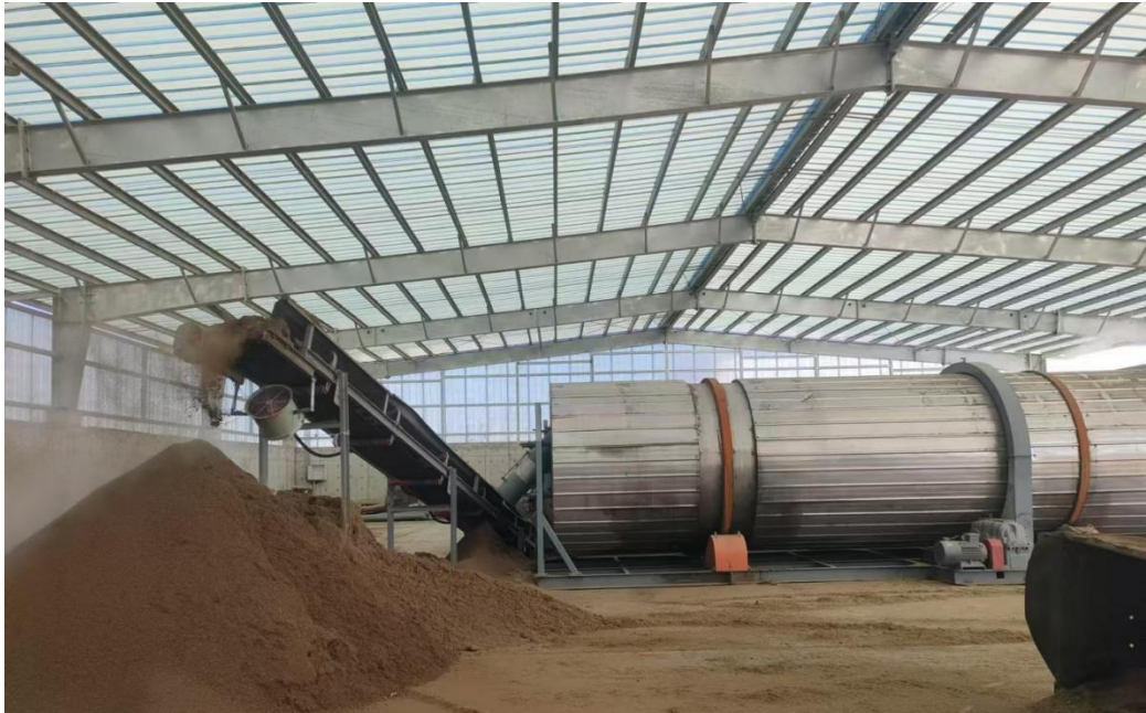
图 3 粪污处理托管运行模式—卧式发酵罐
